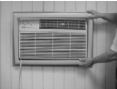
3. Pase el cable a través del marco de terminación y deslice el marco sobre la unidad hasta que quede nivelado con la pared.
