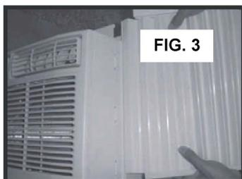
5. Une fois les panneaux en accordéon mis en place, ajustez les rails supérieur et inférieur des panneaux en accordéon sur les rails supérieur et inférieur du climatiseur (voir FIG. 4).
