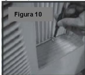
2. Coloque los tornillos de 1/2" (12,7 mm) en la parte superior del marco del panel de acordeón y en la guía superior para fijar firmemente el aire acondicionado de ventana a la hoja inferior de la ventana. (Consulte las Figuras 11 y 12).
